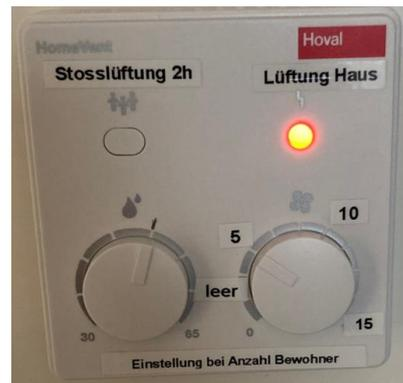
In der Küche befindet sich die Steuerung der Lüftung. Derjenige Drehknopf mit dem Wassertropfen muss immer auf der abgebildeten Position sein.
